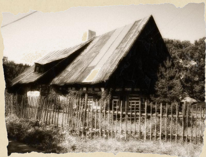
Zabytkowy dom nr 61 w Wieściszowicach. 2
